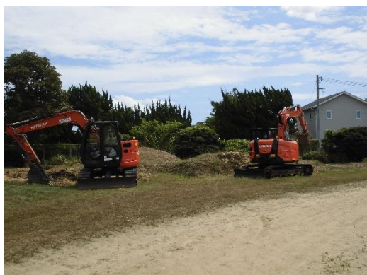
C：建設機械の運転
