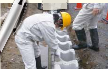
間知ブロックの敷設
