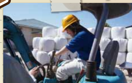
バックホーの運転操作
