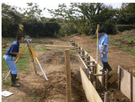
水が反対に流れないように・・・高さを測定中。
